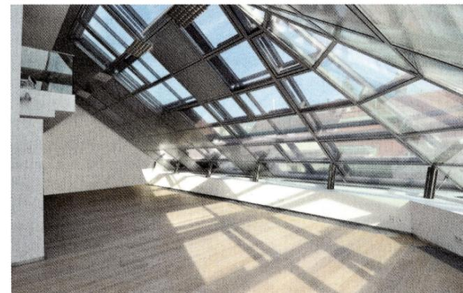
Im Wechselspiel: die Metall- und Glaselemente der Dachkonstruktion
