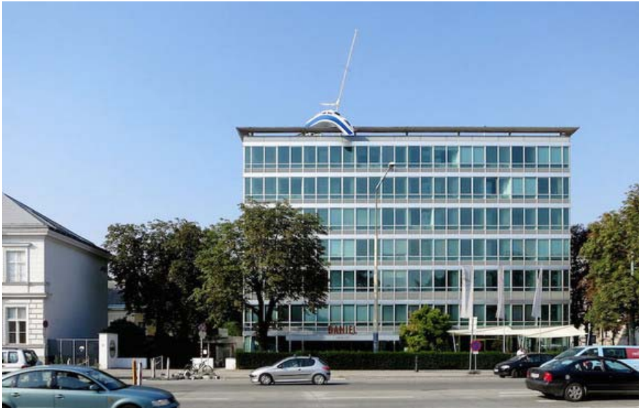
Das Boot hat nicht ein Tsunami aufs Dach des Hotels gehoben, sondern der Künstler Erwin Wurm.
