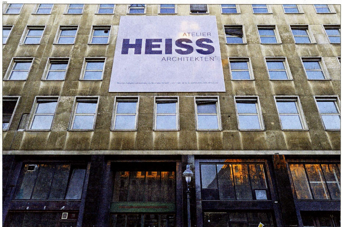
Hässlich auf den ersten, ein kleiner architektonischer Schatz auf den zweiten Blick: der leere Bau am Schuberttring 10-12. [Clemens Fabry]
